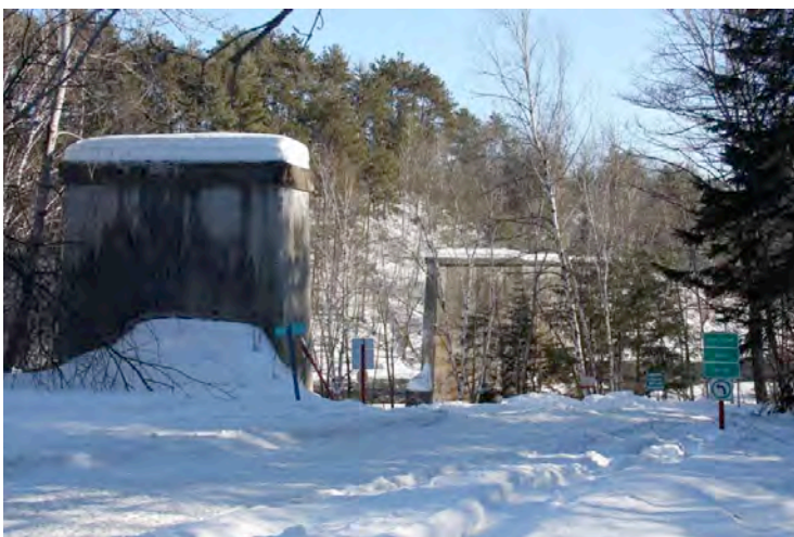
Les piliers du pont ferroviaire enjambant la rivière Ouareau, Rawdon. IMG_3685.jpg
