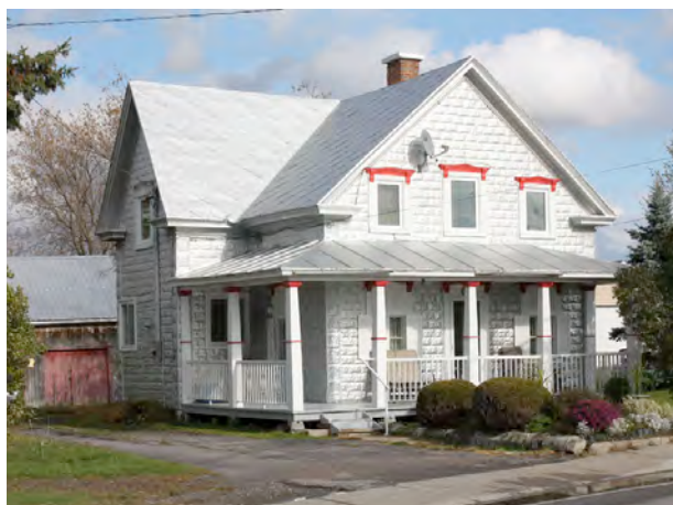
Un revêtement mural de tôle embossée au 3950, rue Principale à Saint-Félix-de-Valois. IMG_0173.jpg
