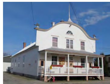
Édifice de type Boomtown, typique avec sa façade au couronnement cintré devant un toit à deux versants droits. Salle J. M. Bellerose, construite vers 1932. 140, rue Saint-Jacques, Saint-Michel-des-Saints. IMG_7307.jpg
