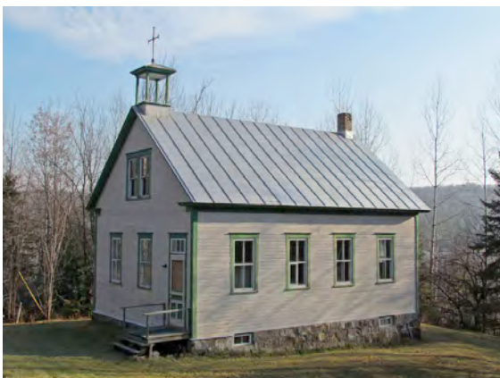
Ancienne école de rang au 2740, chemin des Cascades, Saint-Damien. IMG_7609.jpg
