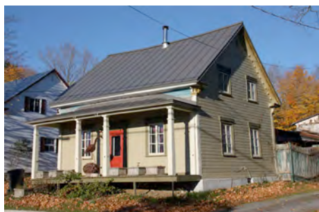
Édifice où les revêtements, les ouvertures et les composantes décoratives sont parfaitement préservés au 295, rue Sainte-Louise, à Saint-Jean-de-Matha. IMG_0460.jpg
