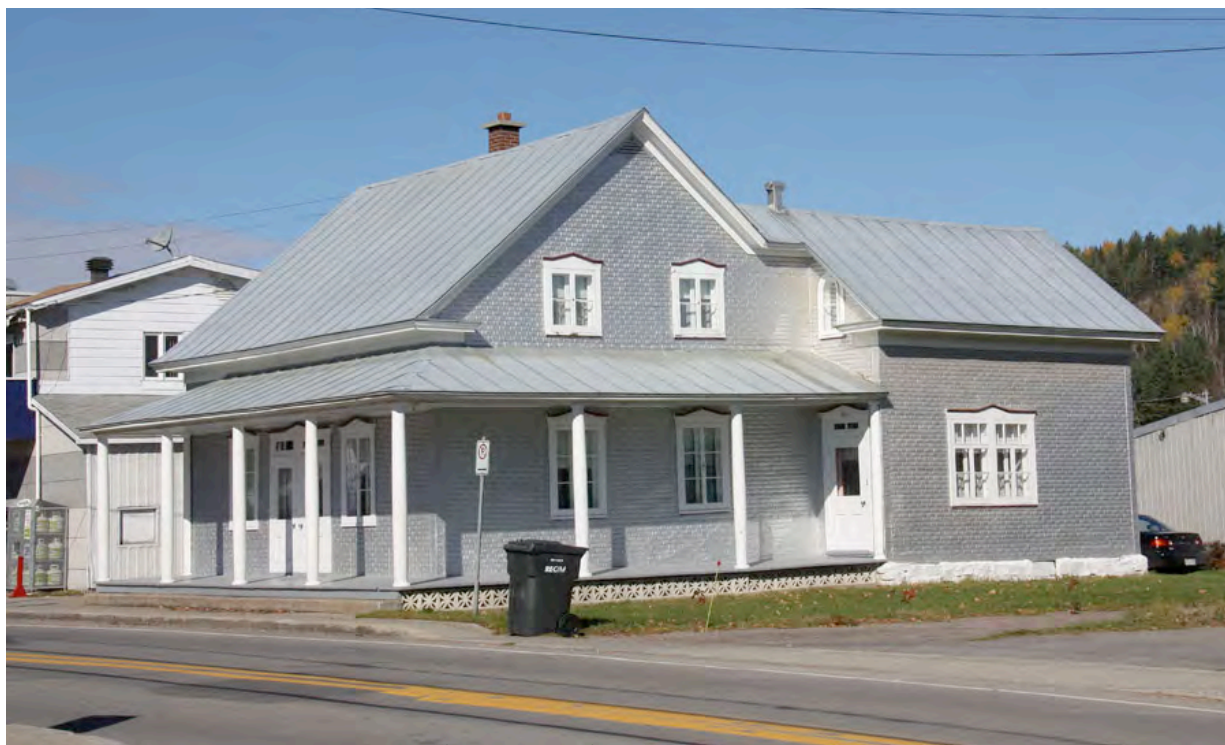
Le 395, rue Saint-Michel, Sainte-Émélie-de-l'Énergie, un modèle courant d'édifice en Matawinie, inspiré par l'architecture néoclassique. Revêtu de tôle embossée, le bâtiment présente une parfaite authenticité architecturale. IMG_0610.jpg
