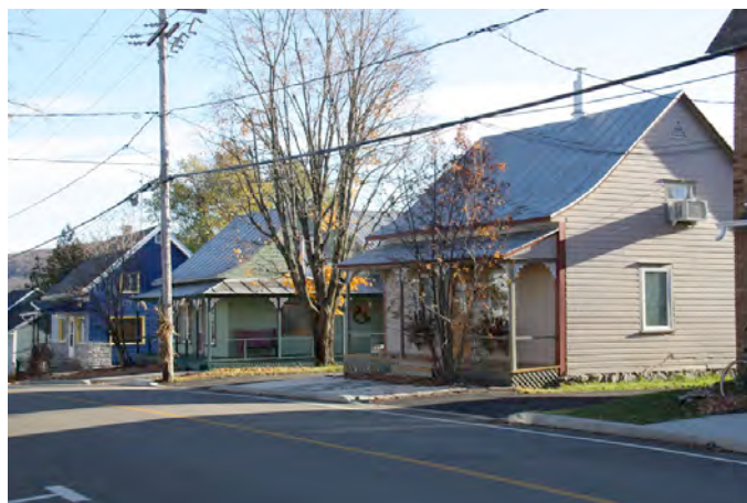
Concentration de bâtiments anciens au gabarit homogène le long de la rue Principale à Saint-Damien. IMG_1009.jpg
