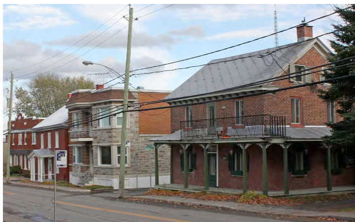
Concentration d'édifices en brique sur la rue Principale à Saint-Félix-de-Valois, unique en son genre dans la MRC de la Matawinie. IMG_0224.jpg
