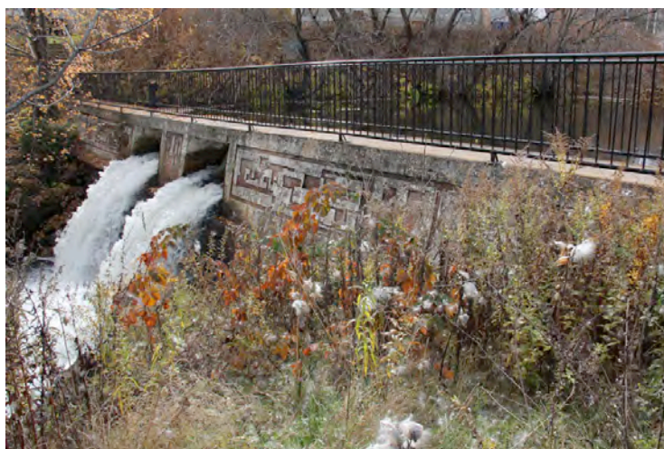
Le barrage du parc de l'Étang-du-Village, Sainte-Marcelline-de-Kildare. IMG_1180.jpg
