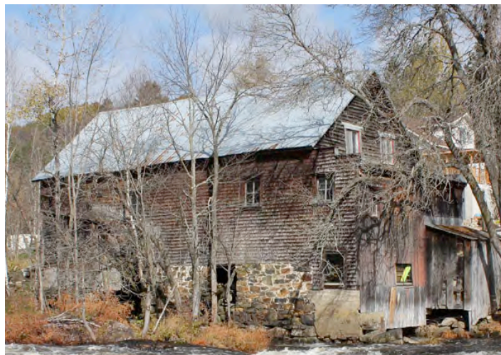
L'ancienne scierie Roméo-Beaulieu, un imposant édifice situé le long de la rivière Blanche à Saint-Jean-de-Matha. IMG_0336.jpg
