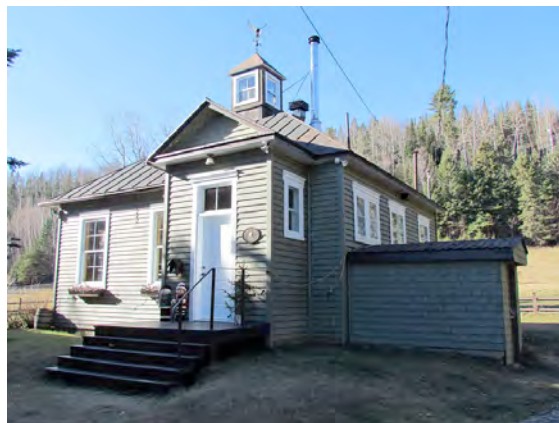
Ancienne école de rang au 7251, chemin Gouin, Saint-Zénon. IMG_7494.jpg
