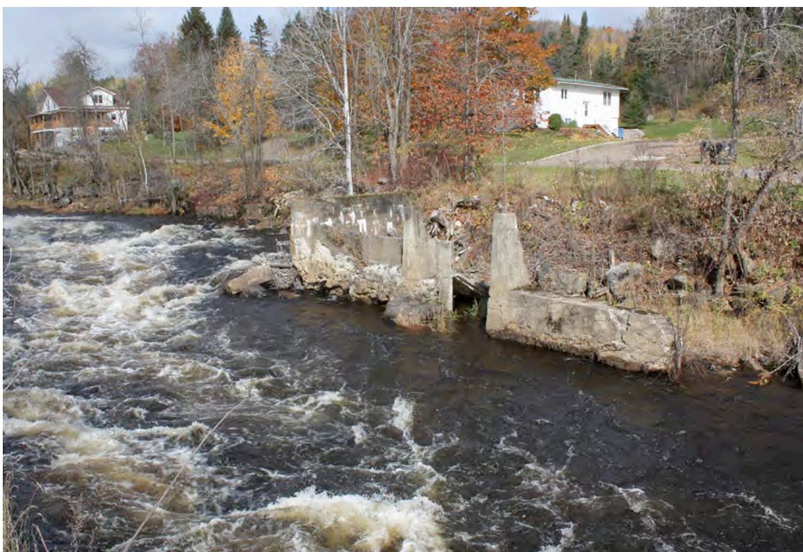
Vestiges d'un barrage lié vraisemblablement à l'opération de l'ancien moulin Roméo-Beaulieu, situé en amont, le long de la rivière Blanche, Saint-Jean-de-Matha. IMG_0337.jpg
