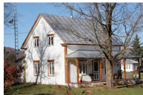
Autre édifice domestique présentant une parfaite intégrité architecturale au 6011, chemin Montauban à Saint-Damien. IMG_0944.jpg
