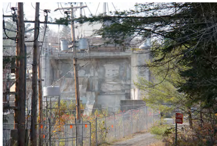
Le barrage de Rawdon. IMG_1461.jpg
