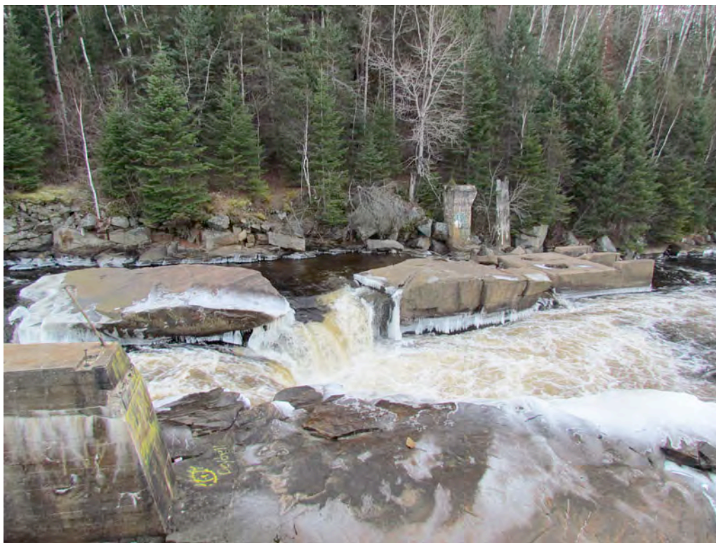
Vestige du barrage de la Shawinigan Water and Power Company, chemin du Lac-Taureau, le long de la rivière Matawin, Saint-Michel-des-Saints. IMG_7373.jpg
