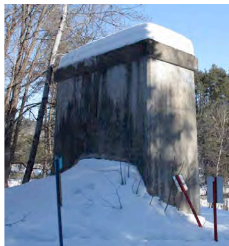
Détail d'un pilier du pont ferroviaire, Rawdon. IMG_3677.jpg
