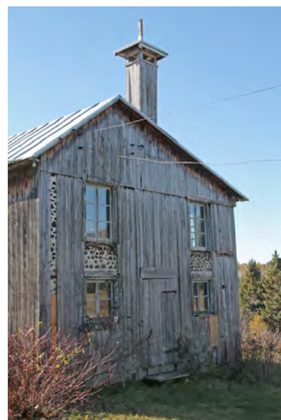
La structure de l'ancienne porcherie est en billes sur billes. IMG_0559.jpg
