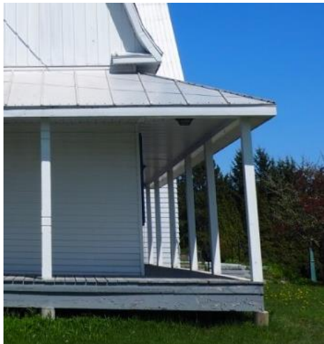
Le porche d'entrée en bois couvert sur deux côtés
