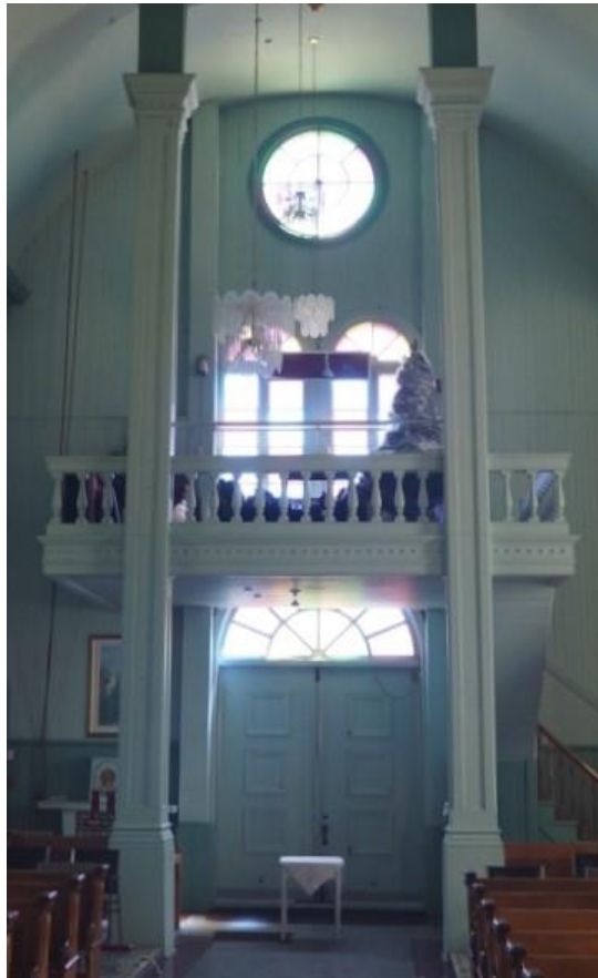
Tribune avant, composée d'un garde-corps, d'une corniche et de deux colonnes doriques en bois ouvragé
