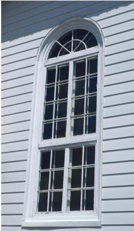
Fenêtres de bois à doubles battants à carreaux et meneaux en bois ouvragé
