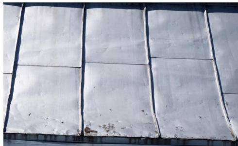
Revêtement de toiture en tôle pincée
