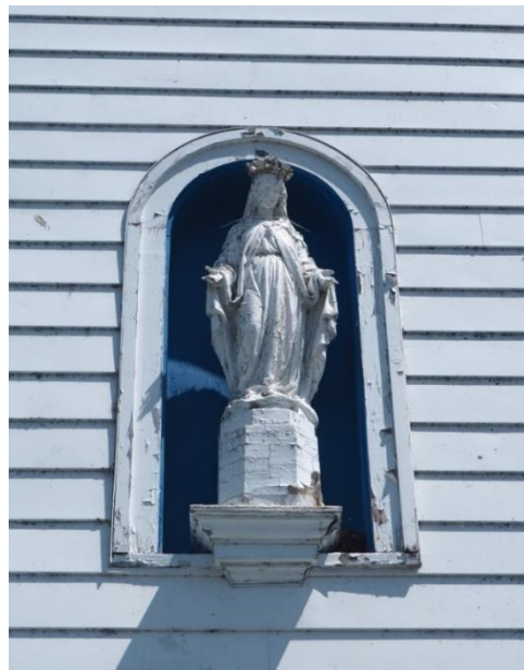
Statue logée dans une niche (façade principale)
