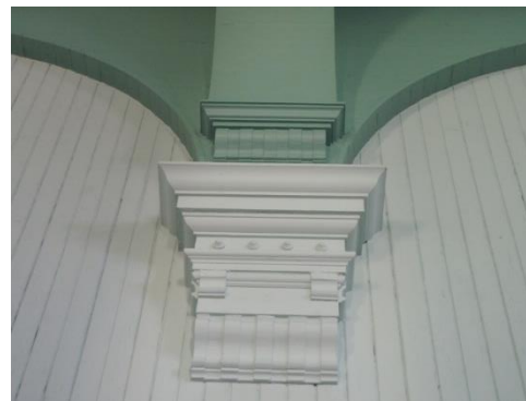
Consoles en boiserie ouvragées
