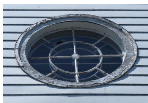
Oculus (façade principale)
