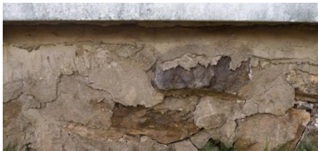
Fondation en pierre à moellon
