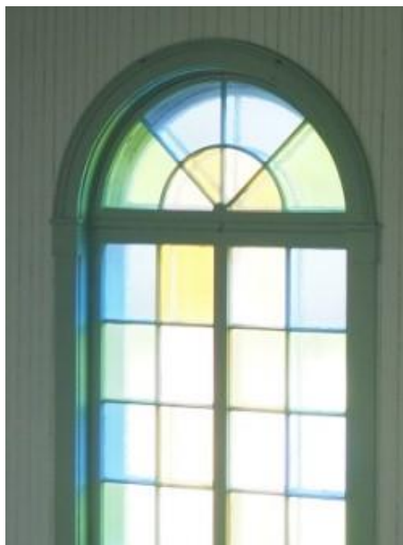
Chambranles en bois ouvragé encadrant les ouvertures (portes et fenêtres)
