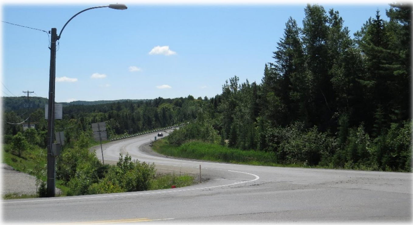
Figure 12 — Visibilité restreinte par la configuration de la route
