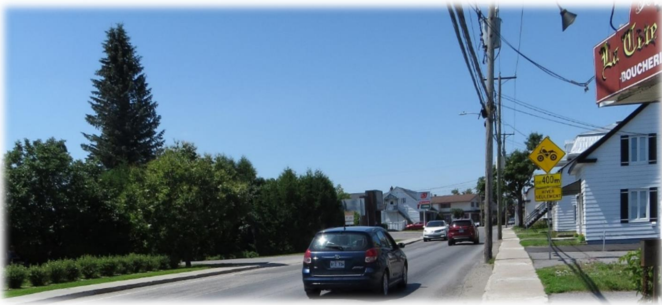
Figure 18 — Implantation de poteaux d'Hydro-Québec dans la chaussée
