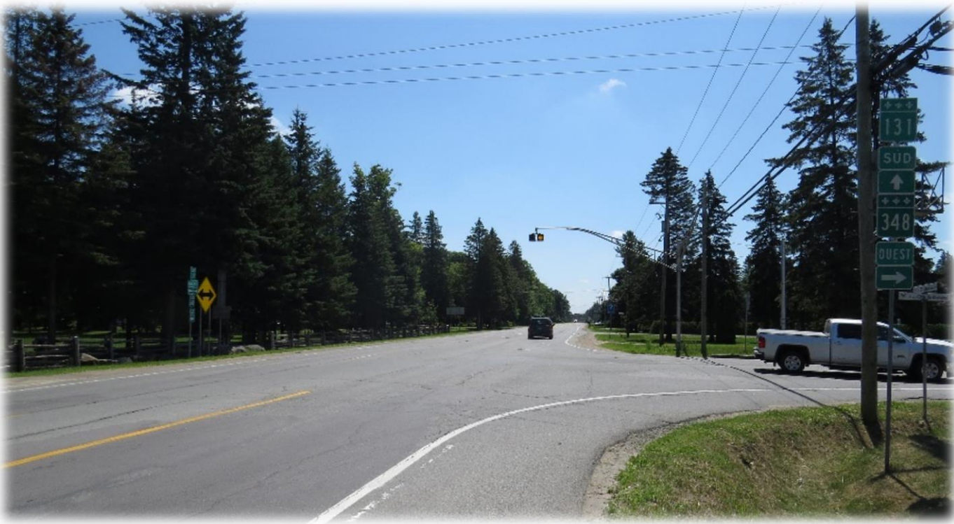
Figure 20 — Signalisation inadaptée au contexte
