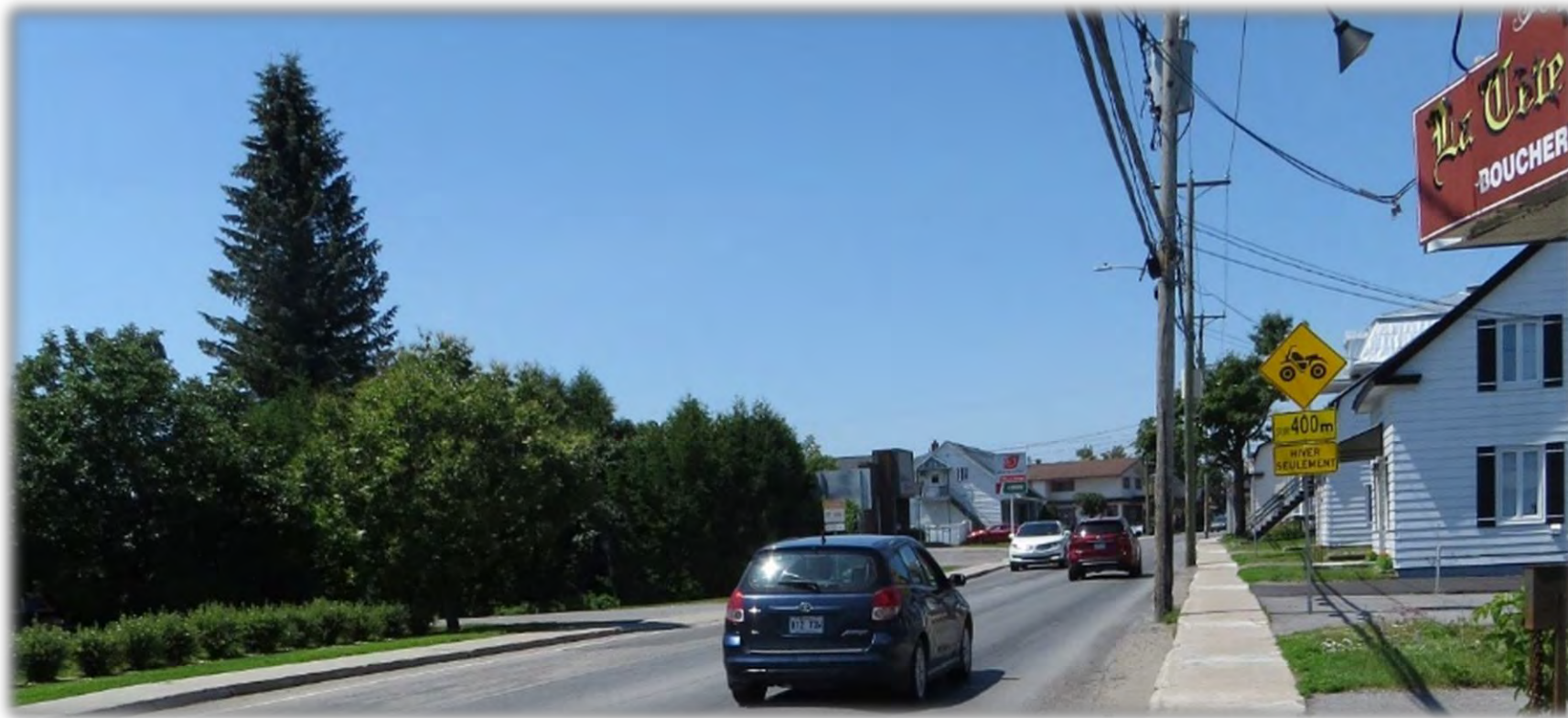
Figure 18 — Implantation de poteaux d’Hydro-Québec dans la chaussée
