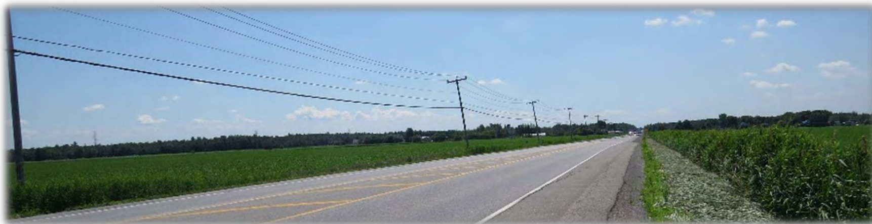
Figure 14 — Absence d'écran brise-vent
